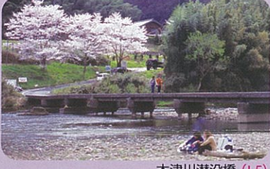
木津川潜没橋 (I-5)
