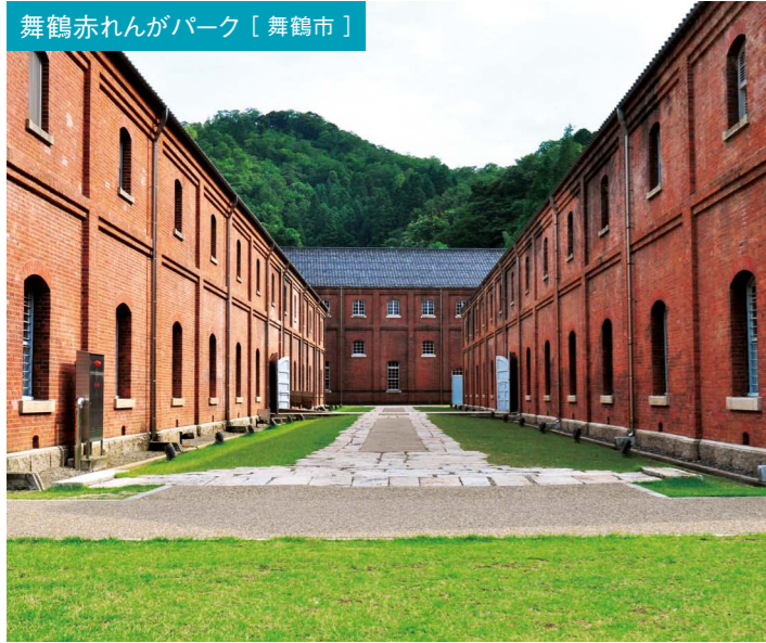
歴史的建造物である赤れんが倉庫群。カフェや展示施設に再生され、舞鶴のシンボルに。
